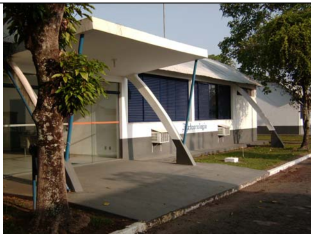
- Vista lateral/frontal do Pavilhão de Meteorologia
